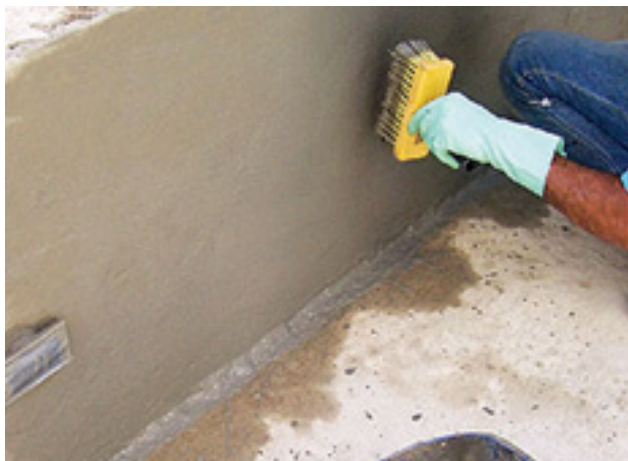
Figura 11 - Aplicação de Argamassa
