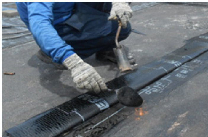
Figura 12 - Manta asfáltica aderida a maçarico
