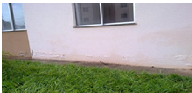
Figura 4 – Ex. de Infiltração por Capilaridade
