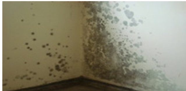
Figura 10 - Bolores decorrentes de umidade
