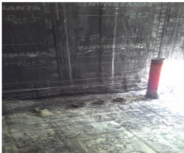
Figura 16 - Detalhe processo de impermeabilização
