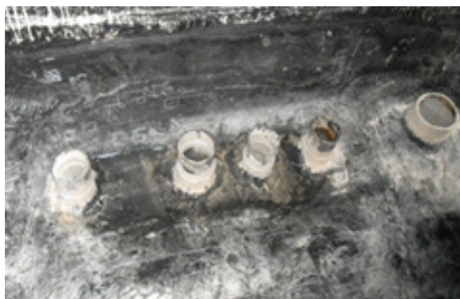
Figura 22 – Detalhe Reparo Aprovado
