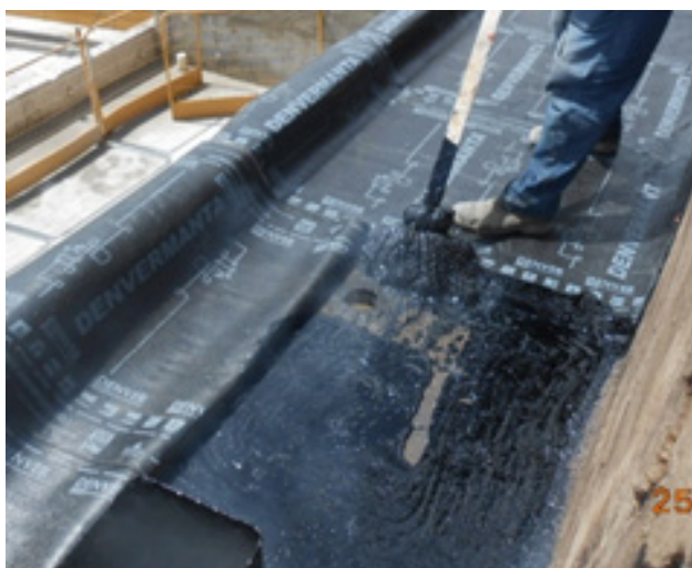
Figura 13 - Manta asfáltica aderida a asfalto aquecido
