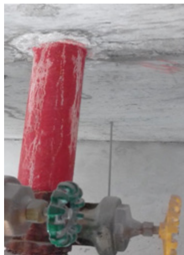
Figura 17 - Infiltração pelo Tubo
